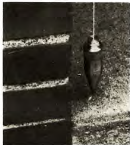
Σχήμα 4-1 Οι χτίστες μεταχειρίζονται το νήμα της στάθμης για να δεδαιωθούν ότι ένας τοίχος είναι κατακόρυφος.
