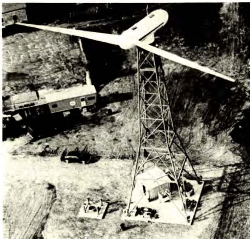
Σχήμα 10-2 Η «στροβιλογεννήτρια» στο νησί Bloch στο Rhode Island. Η θεωρία πίσω από τη σύγχρονη αυτή κατασκευή είναι ίδια με του παλιού ανεμομύλου του σχήματος 10-1. Με πτερύγια που έχουν συνολικό μήκος 38,1 m, αυτή η γεννήτρια παράγει 2,0 \times 10^5 W ηλεκτρικής ενέργειας με ταχύτητα ανέμου 8 m/s.
