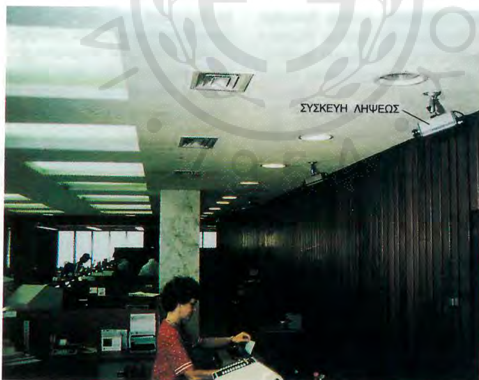
ΣΧΗΜΑ 18.10. Συσκευές λήψεως εικόνων κλειστού κυκλώματος στην τράπεζα αυτή καταγράφουν συνεχώς κάθε κίνηση. Αν η τράπεζα ληστευθεί, εικόνες με τους ληστές θα είναι καταχωρημένες στην ταινία.
