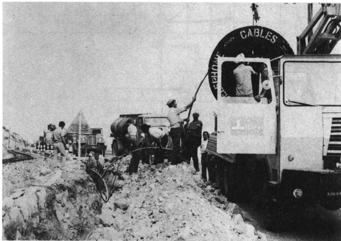
Τοποθέτηση όμοαξονικού καλωδίου σέ χαντάκι.
