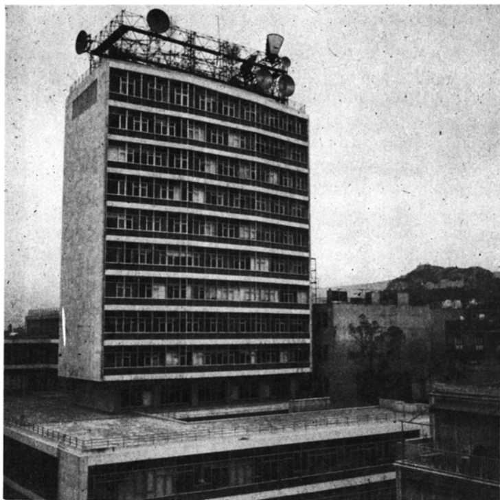
Τό διεθνές καί ὑπεραστικό κέντρο Ἀθηνῶν τοῦ Ο.Τ.Ε, στήν ὁδὸ Γ' Σεπτεμβρίου. Στήν κορυφή του διακρίνονται οἱ κεραῖες μικροκυματικῶν ζεύξεων τοῦ ἐθνικοῦ ὑπεραστικοῦ δικτύου καί τοῦ δικτύου Ἀθηνῶν-Θερμοπυλῶν, γιὰ τή σύνδεση μέ τό δορυφορικό σταθμό ἐδάφους.
