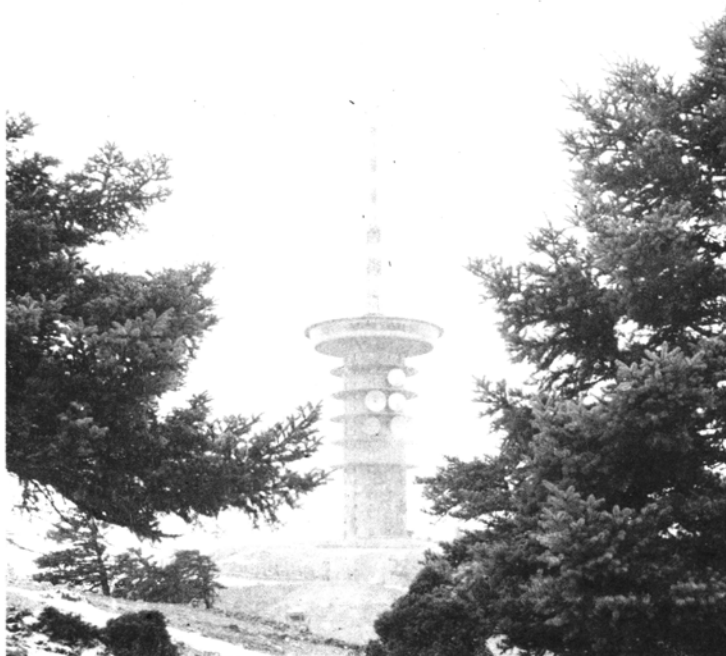
Πύργος σταθμοῦ ἀναμεταδόσεως μικροκυμάτων καί τηλεοράσεως τοῦ Ο.Τ.Ε. Διακρίνονται οἱ παραβολικὲς κεραῖες τῶν μικροκυματικῶν ζεύξεων καί ἡ κεραία τηλεοράσεως στήν κορυφή.
